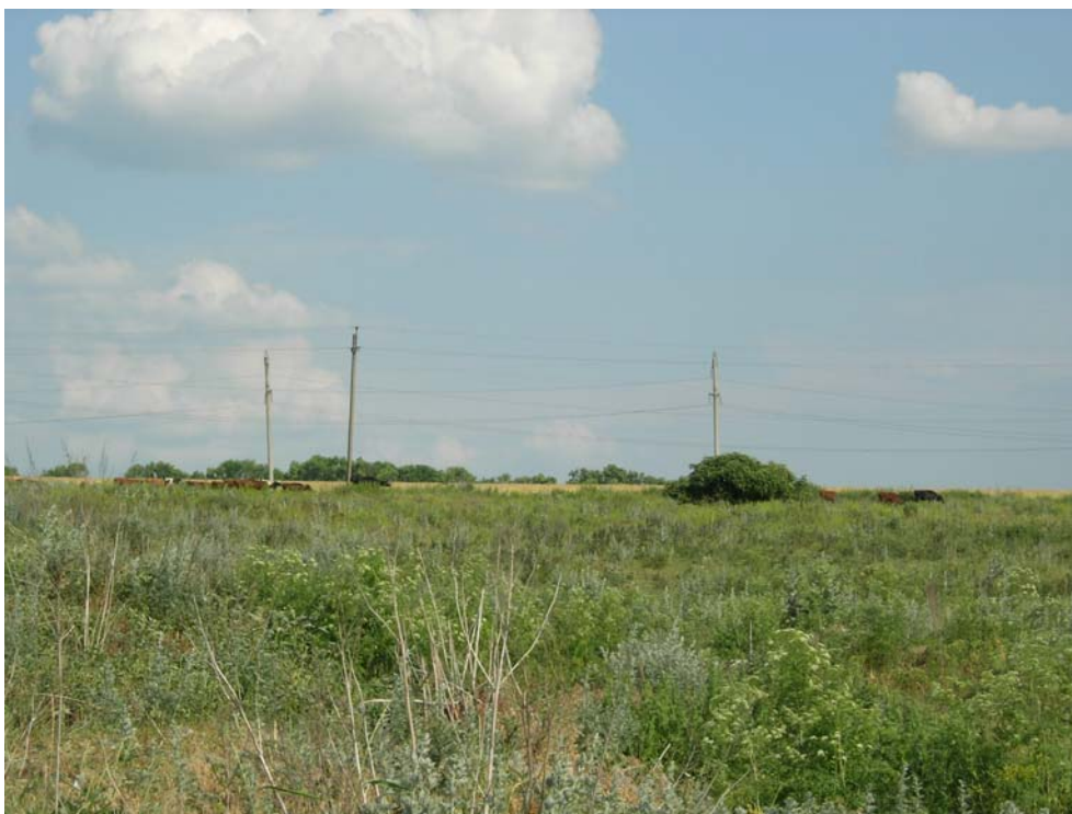
Рис. 3. Высоковольтная линия электропередачи
