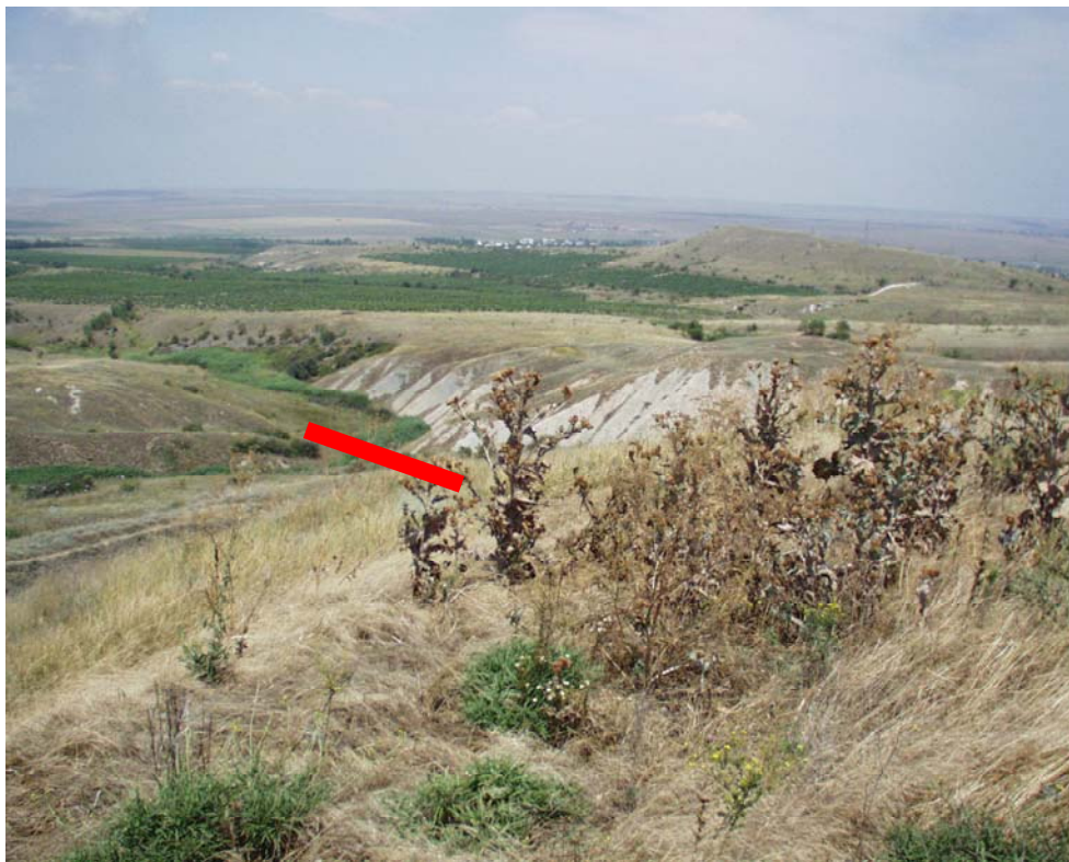
Рис. 23. Феодосийский полигон: положение глиняного барьера для очистки фильтрата
