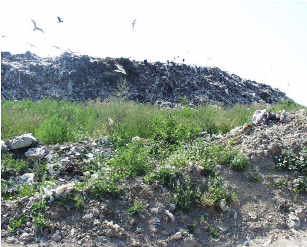
Рис. 36. Симферопольский полигон: откосы
