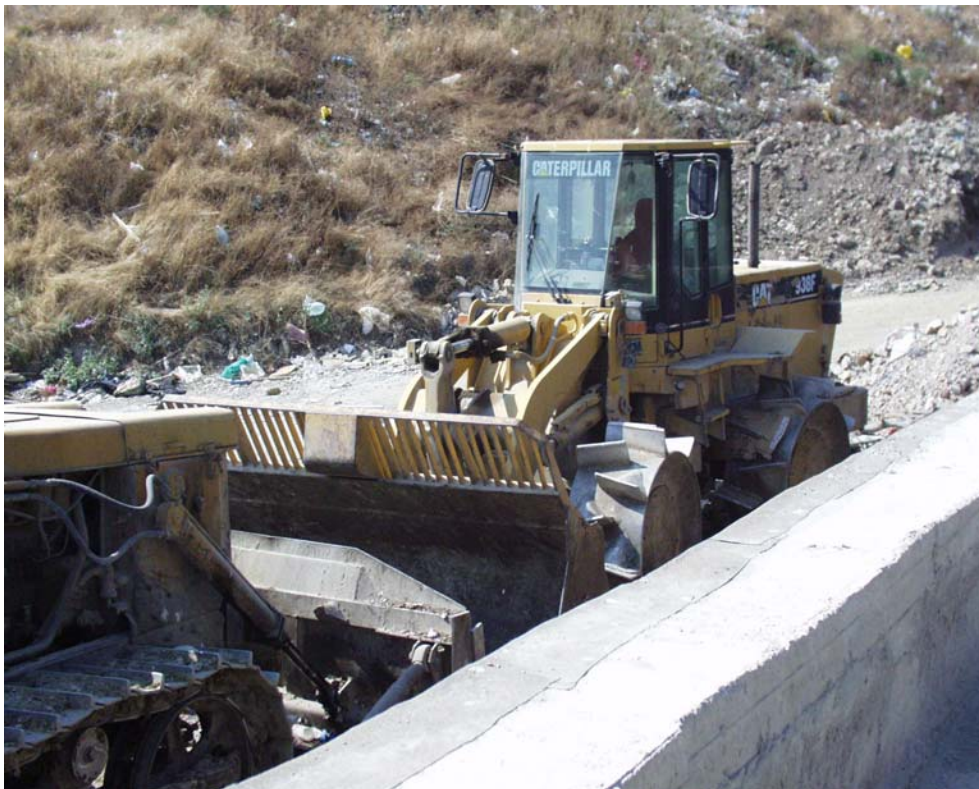
Рис. 50. Ялтинский полигон: каток для уплотнения отходов
