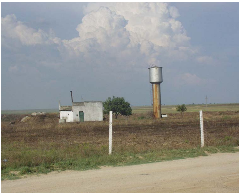
Рис. 13. Евпаторийский полигон: место размещения водонапорной скважины
