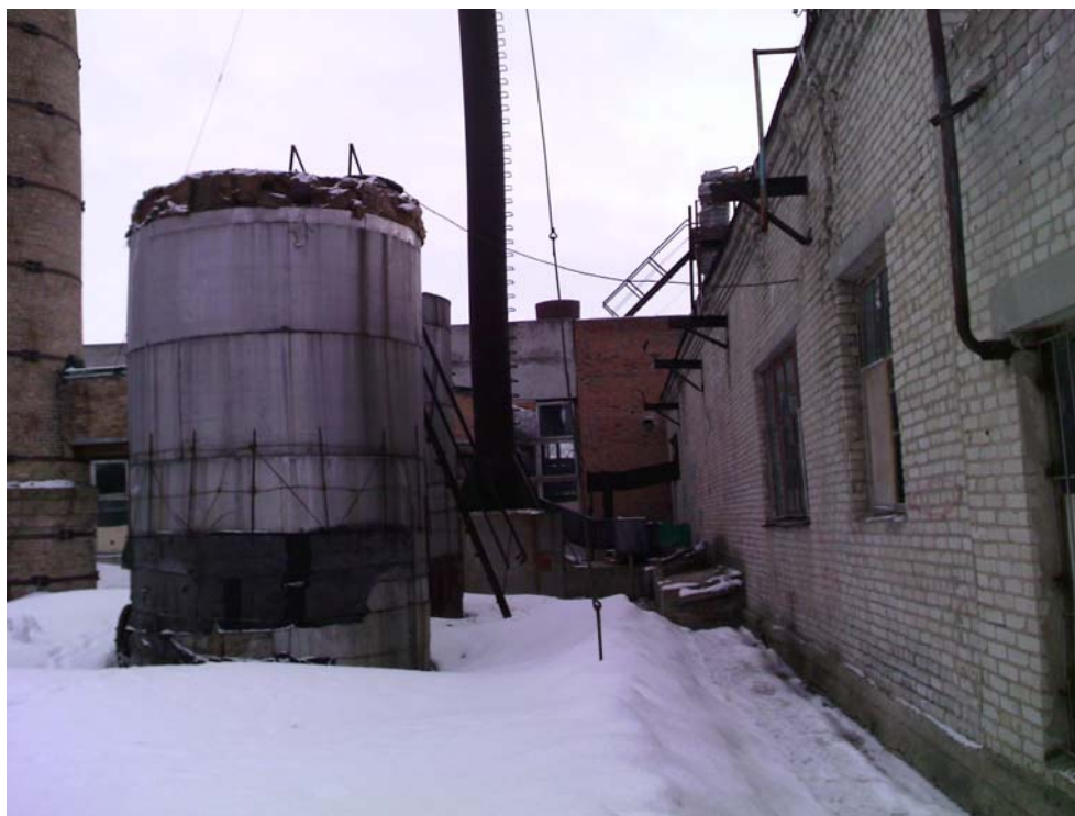
Photo 25 Cour derrière la chaufferie
