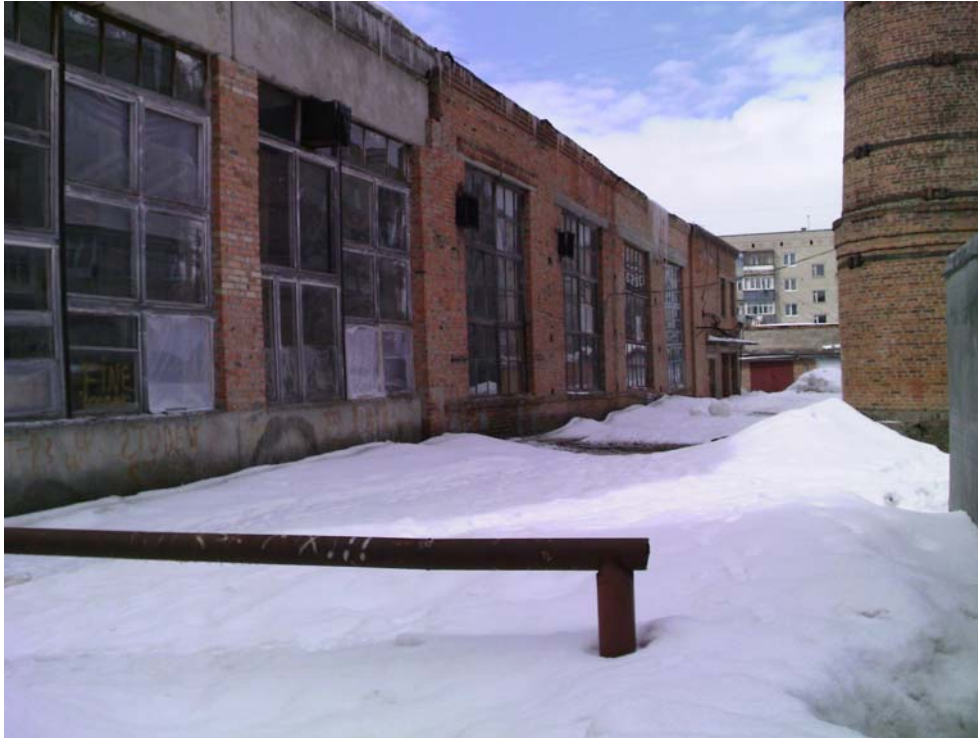
Photo 42 Espace disponible derrière la chaufferie
