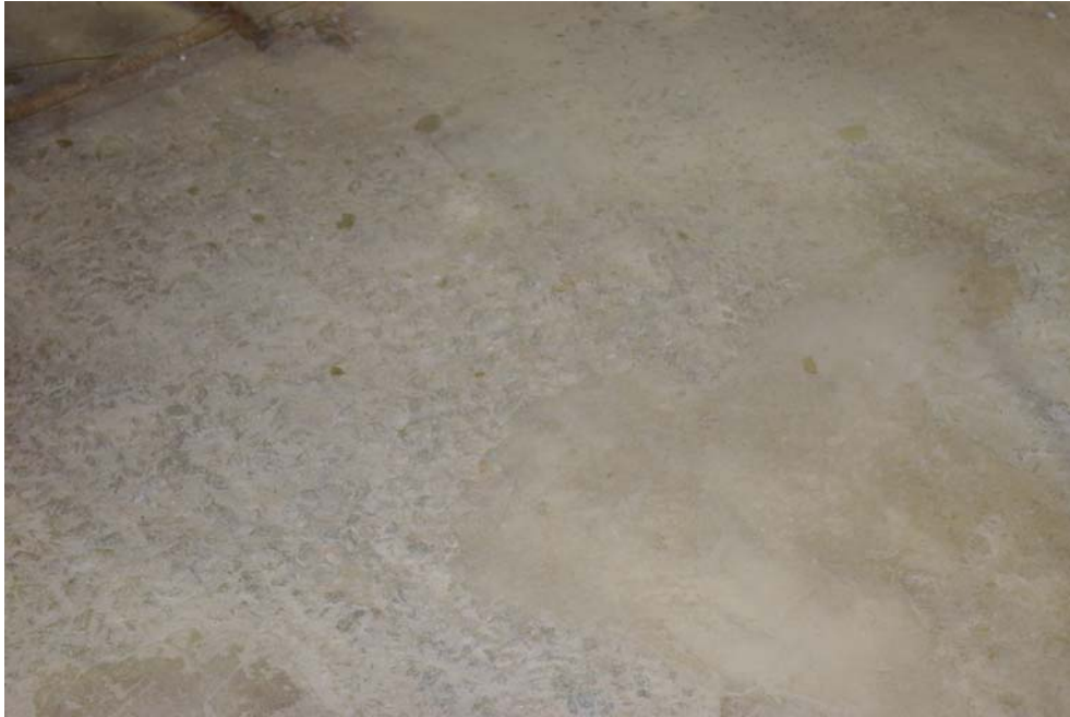
Photo 97 Sol en béton
