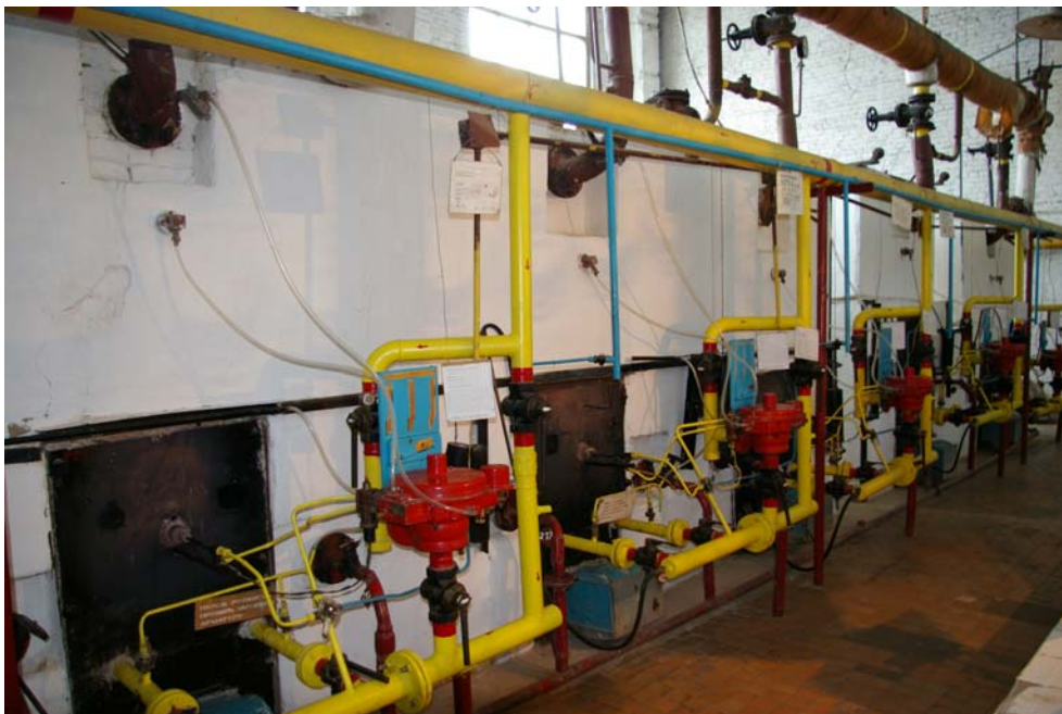
Photo 1 Chaudières à remplacer
