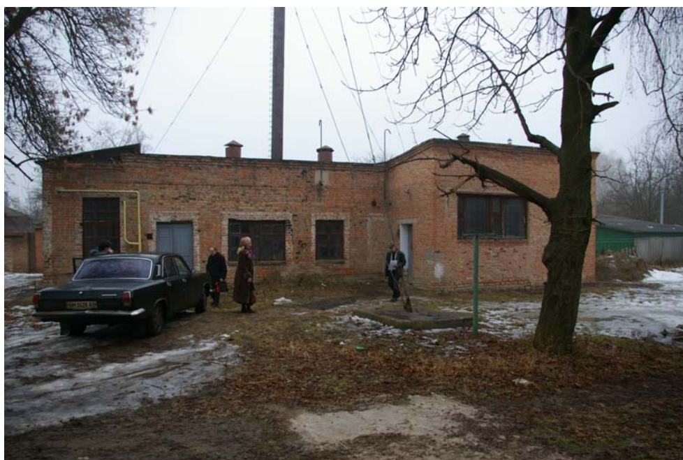
Photo 60 Vue générale du bâtiment
