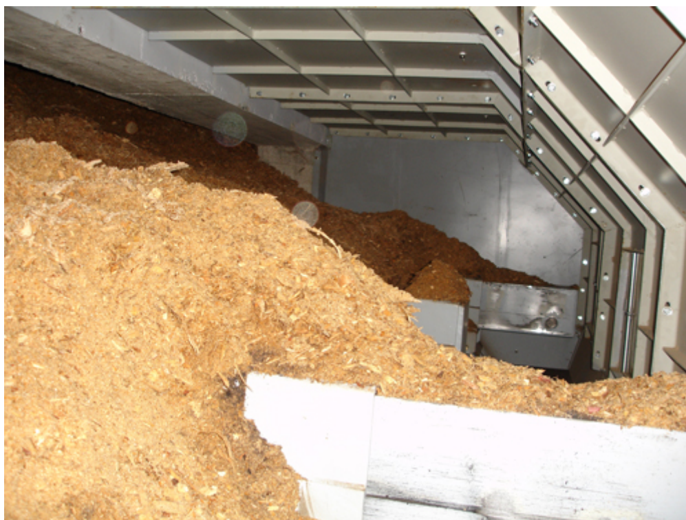
Photo 112 Intérieur du silo
