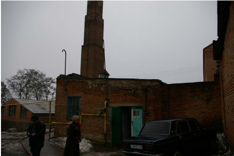
Photo 16 Bâtiment de la chaufferie
