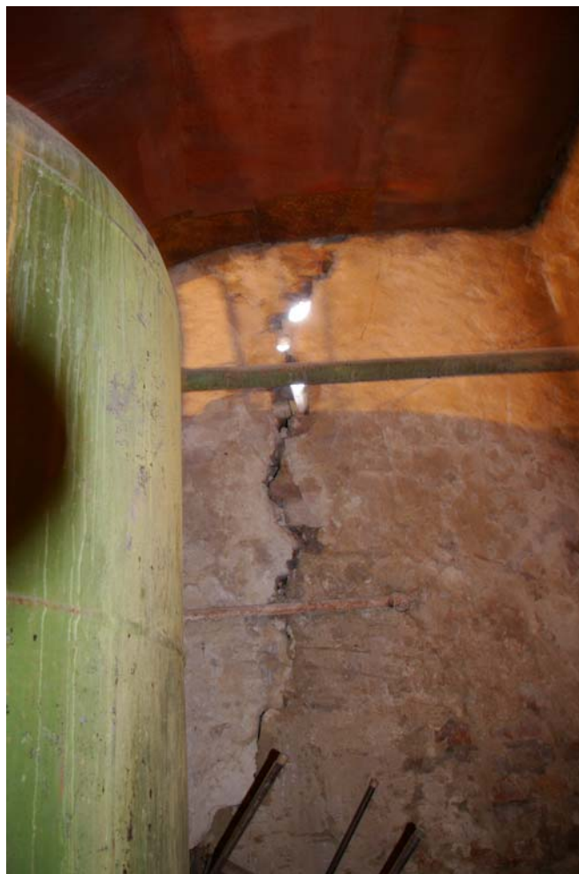
Photo 74 État des murs
