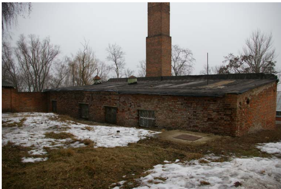
Photo 18 Toit de la chaufferie
