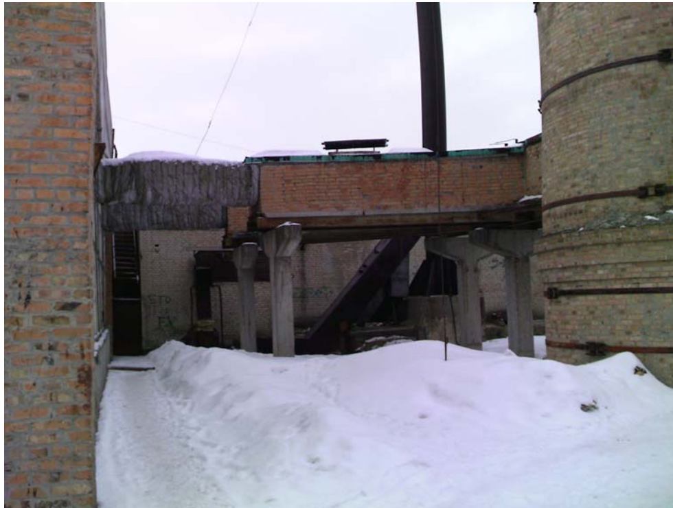
Photo 27 Espace disponible derrière la chaufferie
