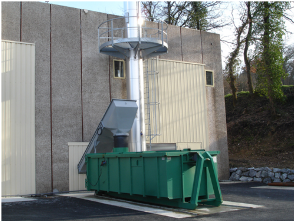
Фото 110 Складування в зйомних блок-контейнерах
