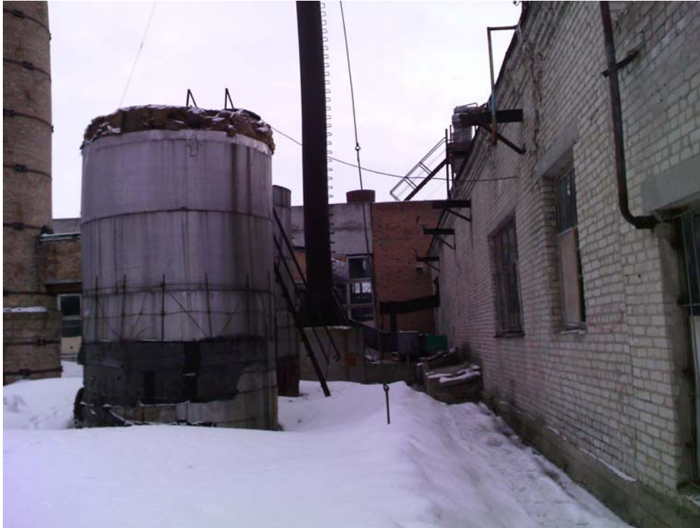
Фото 25 Двір позаду котельні
