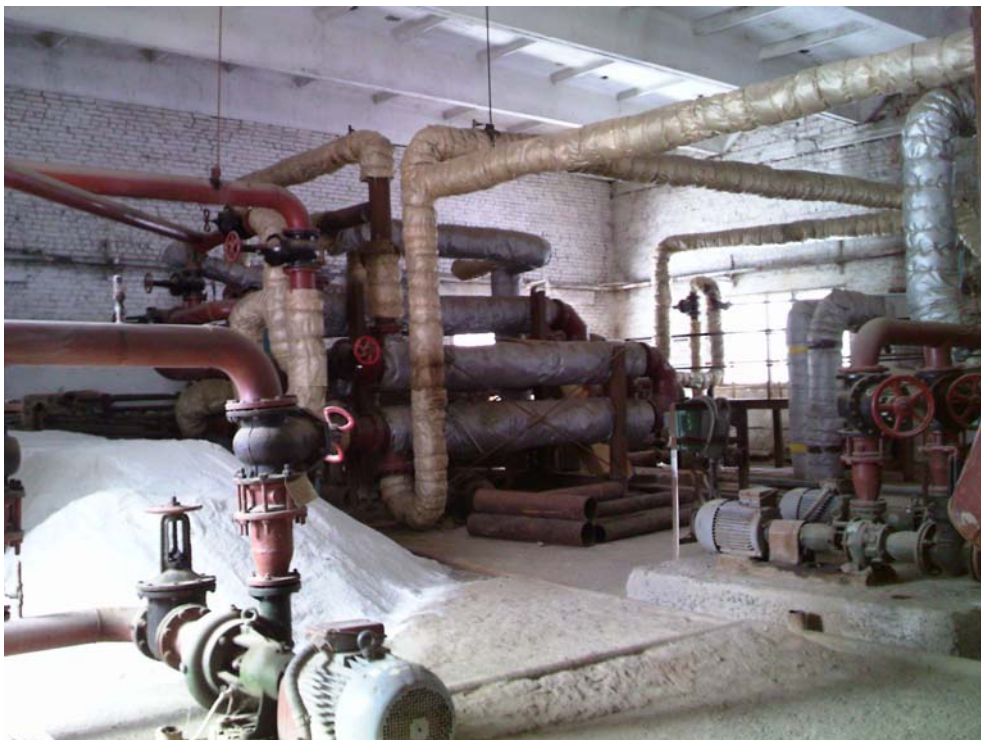
Фото 41 Приміщення придатне для складування
