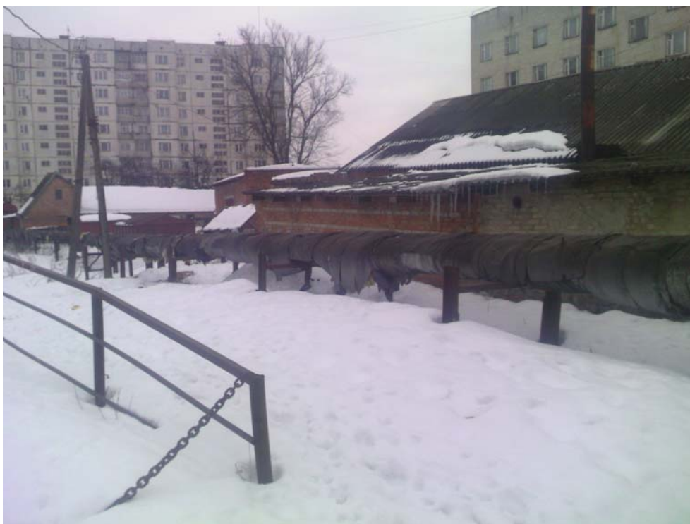
Фото 55 Тильна сторона котельні
