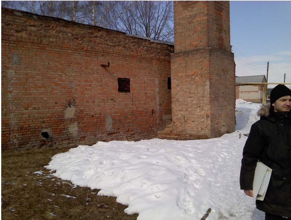
Фото 14 На задньому плані котельні
