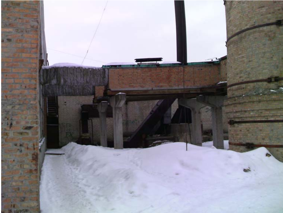
Фото 27 Наявне місце позаду котельні
